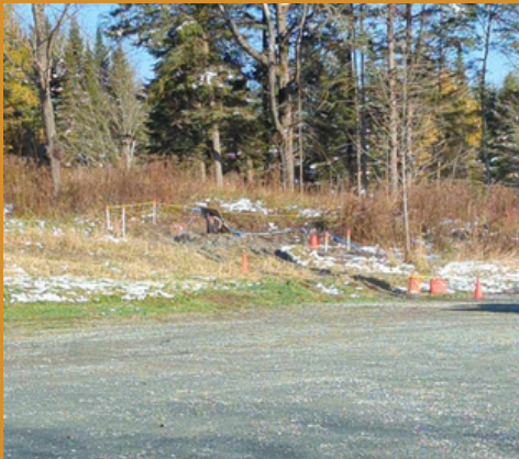
Photo des travaux en cours - CPE Kinnear's Mills
